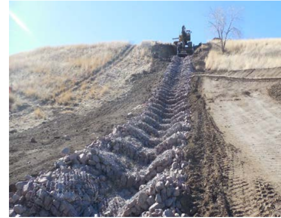
Sundog Landfill Cap Repairs
